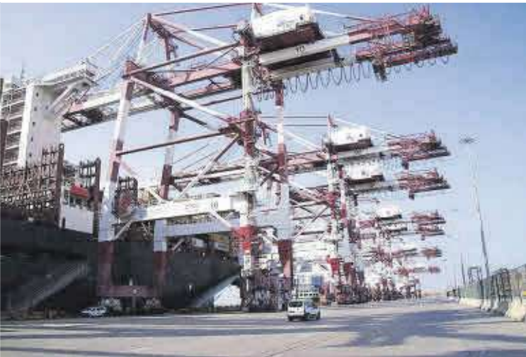
La descàrrega del material al port de Barcelona
